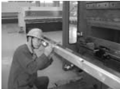
不銹鋼杆角度測量
