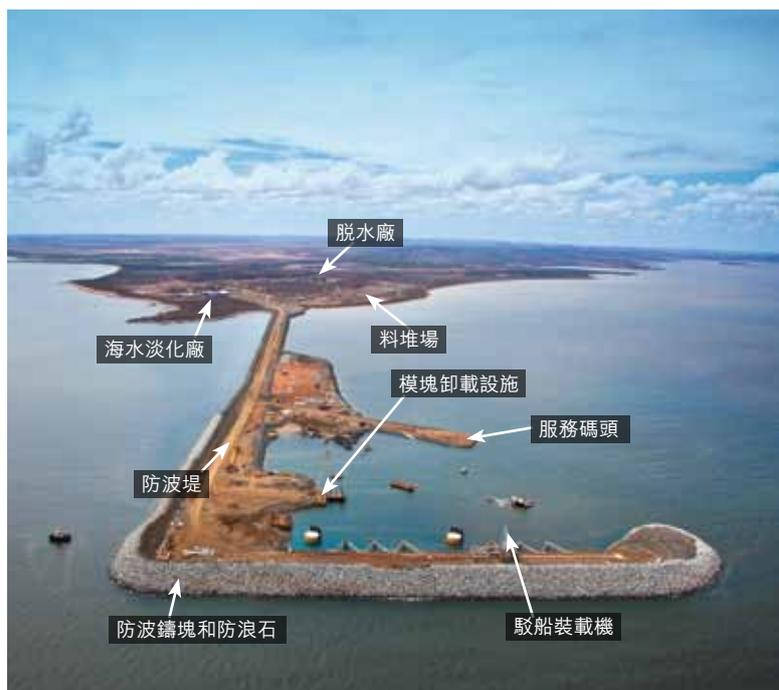
波鑄塊。這些防波鑄塊形成一個“鐵壁銅牆”，保護防波堤免受海浪的衝擊，特別是來自颶風的侵蝕。防波堤和卸載設施的完工也使得主要基礎設施的模塊能夠直接運抵施工現場。用於堆放運到港口精礦的堆料機和裝有10個帶輪翻轉斗車的取料機也將近建好。
