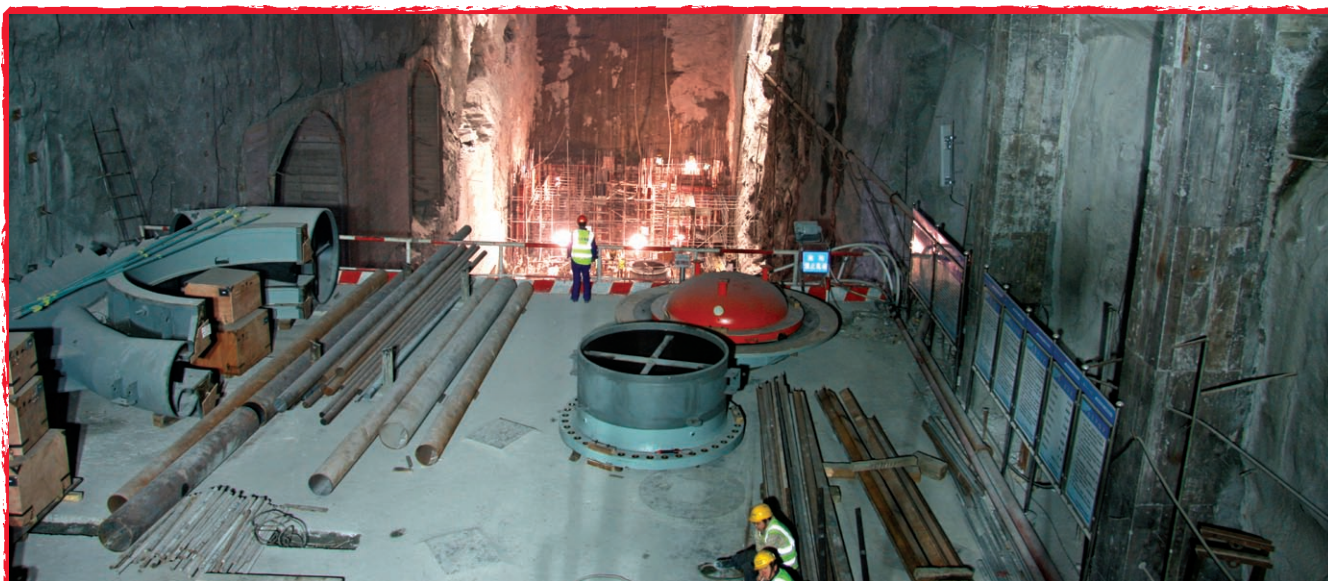
江邊水力發電項目施工中的地下廠房
