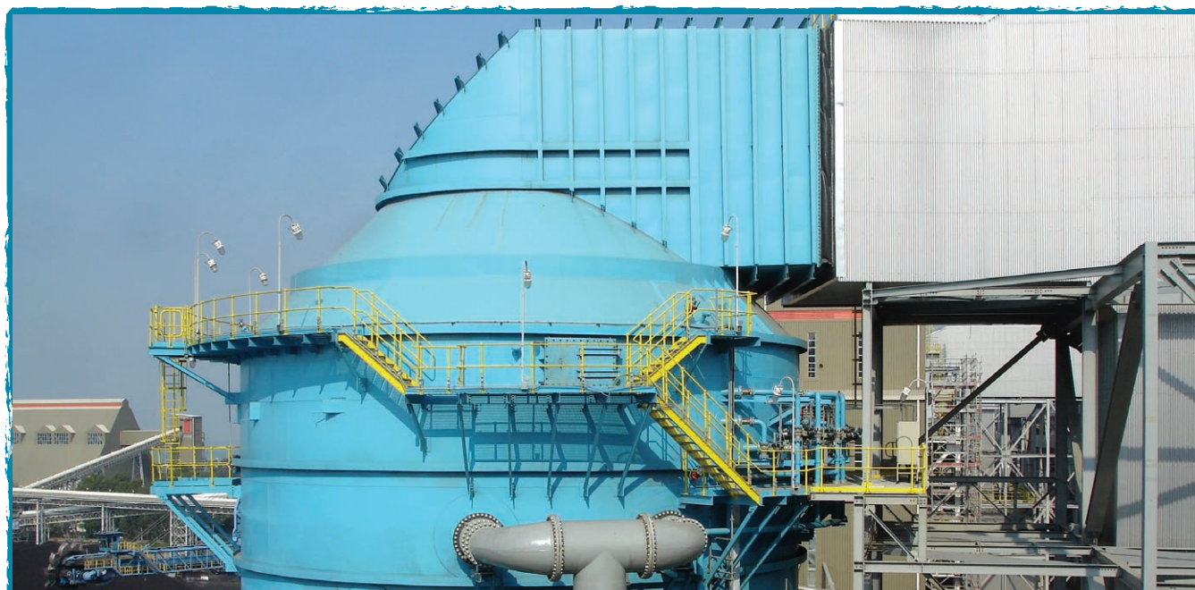
青島發電廠的減排設施 — 新的吸收塔可清除煙氣內的二氧化硫
