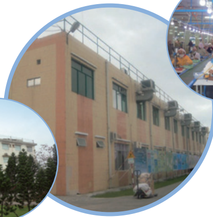
▲ 越南峴港市第一間廠房
