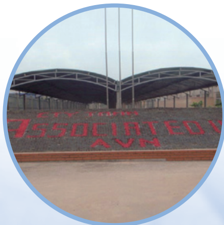
▲ 越南峴港市第三間廠房
