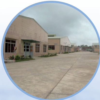
▲ 越南峴港市第三間廠房
