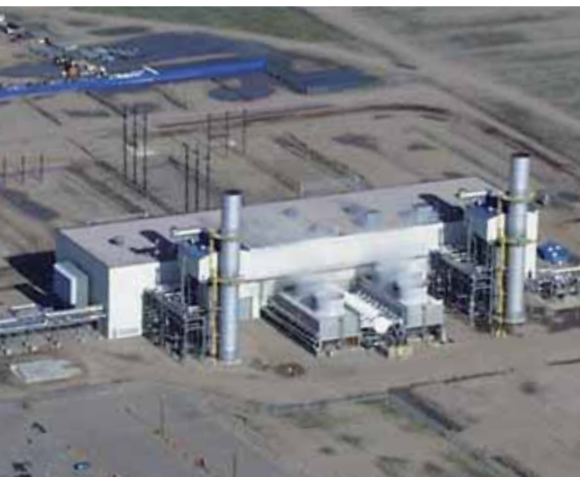
位於薩斯喀徹溫省的 Meridian Cogeneration Plant。
