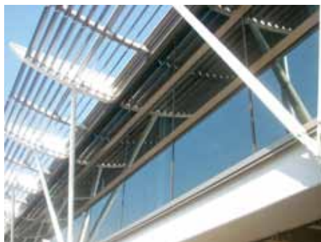
香港國際機場北衛星候機大樓玻璃幕牆工程
