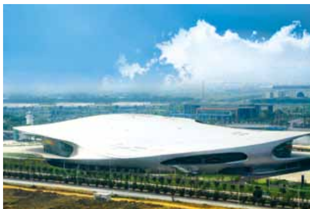
廣州亞運會綜合館金屬屋面工程
