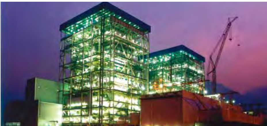
中國首台沁北電廠600 MW超臨界鍋爐
