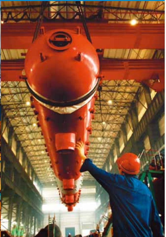
電站鍋爐正在吊裝
