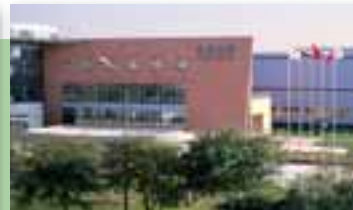
北京泰德廠房
