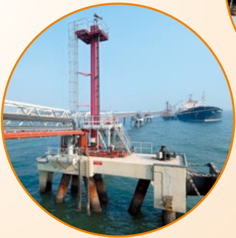
位於屯門之 香港航空燃油設施 啟用
