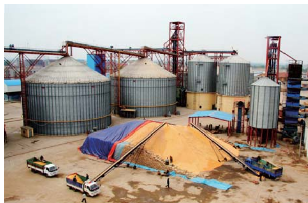
○ 合理佈局，提高產區原料倉儲能力
