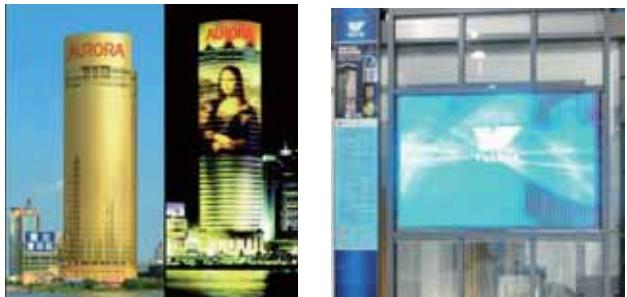
視頻幕牆匯合了幕牆及LED視頻控制技術。由於幕牆表面應用LED屏幕，該幕牆可通過幕牆的顯示及音頻控制系統達成多項視頻及音頻效果。
