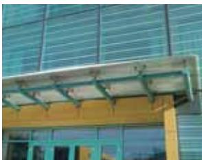
雨篷系統是一幢建築物外層的結構組成部分，位於建築物入口及出口處，為建築遮擋風雨及陽光。雨篷系統底下，是一個半開放式的空間，是建築物內部空間與外層空間之間的交流及過渡緩衝地帶。雨篷系統是一幢建築物的外部裝飾系統的重要部分，得以突出整個建築。
