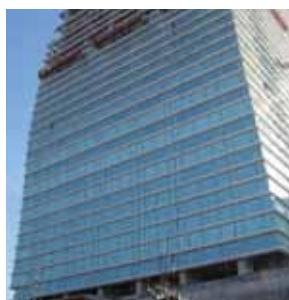
半單元式幕牆具有構件式幕牆及單元式幕牆綜合特色。在我們的生產設施內，除主龍骨之外，半單元式幕牆的所有組件均被製造及裝配成單元式面板，然後運往工地，將其固定於主龍骨之上作安裝之用。
