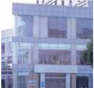
全玻璃幕牆屬另一種無框式幕牆，玻璃面板互相連接，通過周邊支撐結構，最終連接至主大樓。
