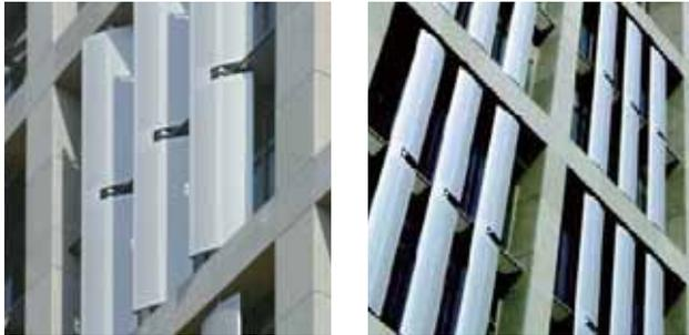
遮陽系統用以讓建築物免受過量陽光照射，從而減少建築物所耗空調量，幫助改善建築物的能源效益。若干遮陽系統採用了智能控制技術，可根據太陽的路徑自動調整位置。
