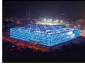
膜結構幕牆為一類採用高性能ETFE膜結構為其表面物料的幕牆，包括ETFE張拉膜結構及ETFE氣膜結構。ETFE膜結構具有多項合宜的物質特性，如高透過度、輕、高度抗老化及長壽。
