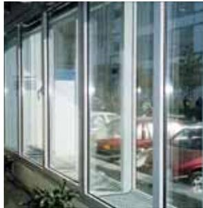
雙層節能幕牆乃外部樓宇結構，包括外部幕牆及內部幕牆。其亦被稱為動力通風幕牆、熱通道幕牆及呼吸幕牆。與傳統幕牆比較，雙層幕牆可有效改善外部樓宇結構的隔熱保暖表現、內部通風、隔音及光線。
