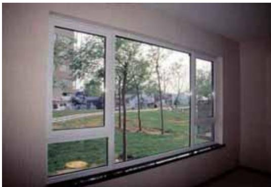
節能環保鋁合金門窗以阻熱鋁合金型材及節能玻璃製成，全部皆為可循環再造的材料。
