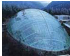
採光頂由透明面板和其支撐系統組成，是水平角度少於75度的屋面系統。為建築物內部提供天然光，並具其他相關功能。透明面板一般由玻璃、聚碳酸酯層以及透明膜材料組成。
