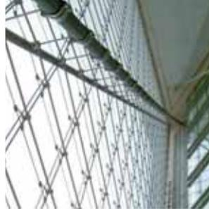
點支式幕牆屬一種無框式幕牆，包括玻璃面板、於該等面板上的點支式組件及其支撐結構。
