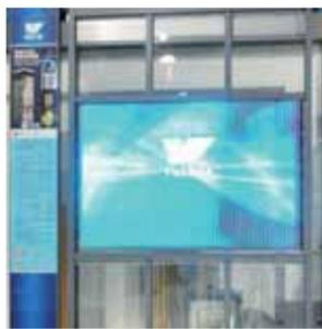
視頻幕牆匯合了幕牆及LED視頻控制技術。由於幕牆表面應用LED屏幕，該幕牆可通過幕牆的顯示及音頻控制系統達成多項視頻及音頻效果。
