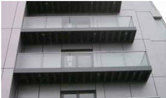
欄杆／欄板系統由應用於建築物某些部分的若干組件組成，用於安全防護及裝飾。作為一個獨立的系統，欄杆／欄板系統常應用於有通道的屋頂邊緣、室內樓邊及露臺。
