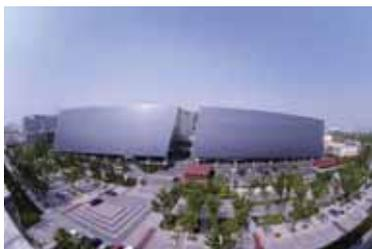
光伏幕牆屬一類結合光伏系統的幕牆。光伏面板一般會安裝於幕牆玻璃，以從太陽能產生電力。
