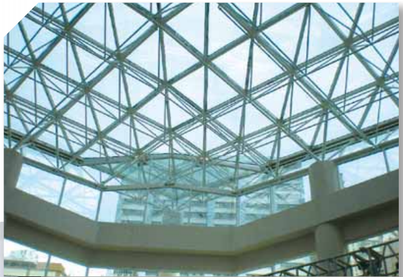
於天窗及玻璃幕牆採用太陽能薄膜
