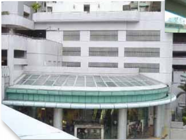
於天窗及玻璃幕牆採用太陽能薄膜
