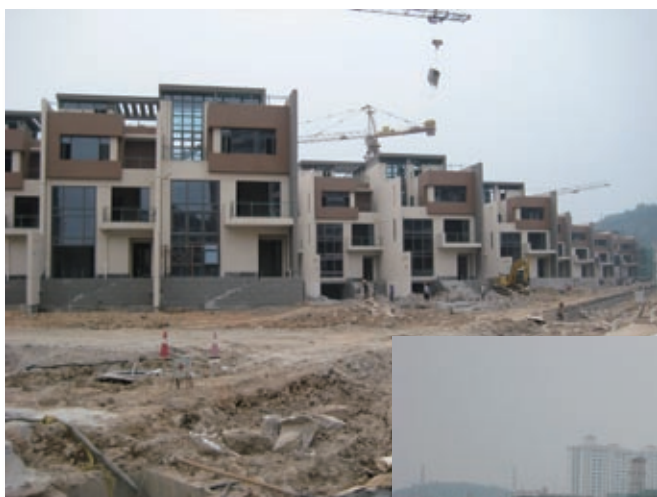
雅瑤綠洲第一期 之聯排別墅 — 建築工程正在進行中
