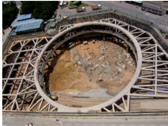
深圳福田區漢國城市商業中心 - 地基工程正在進行中
