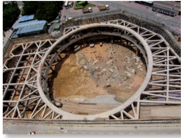
深圳福田區漢國城市商業中心 - 地基工程正在進行中
