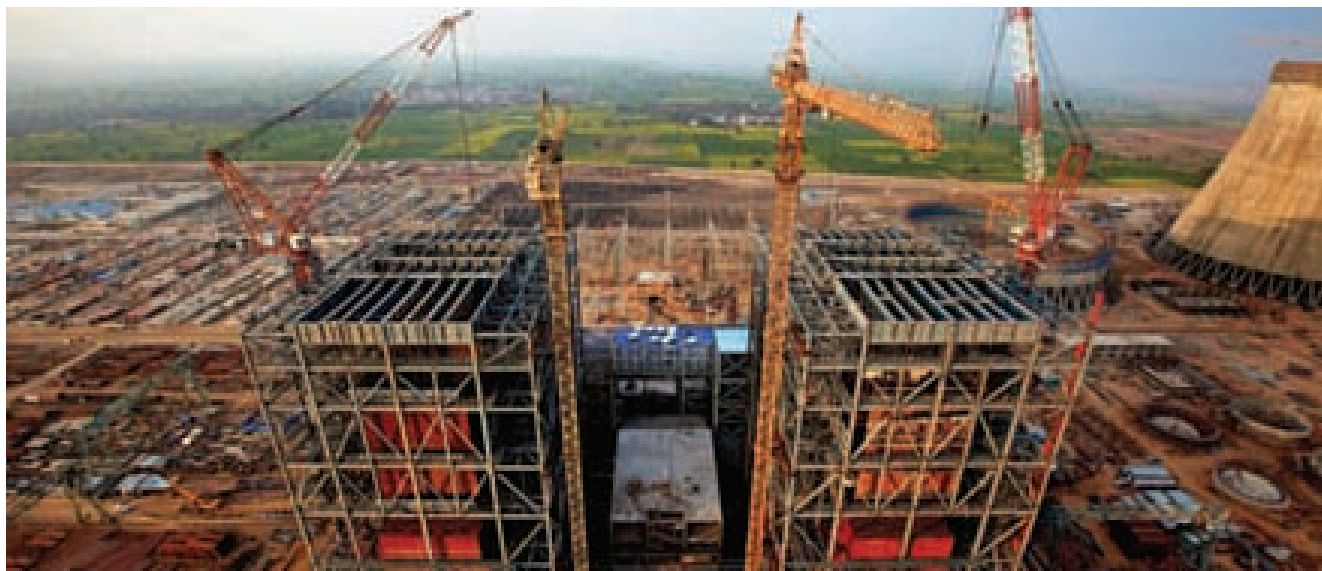
施工中的哈格爾項目
