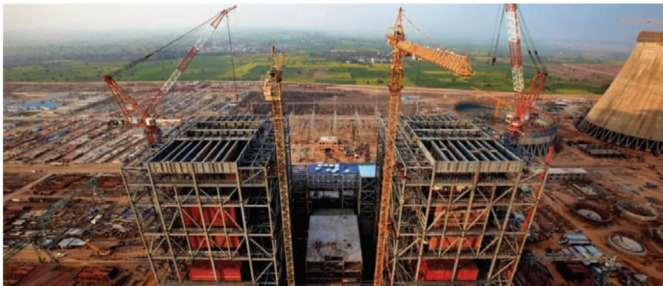
施工中的哈格爾項目
