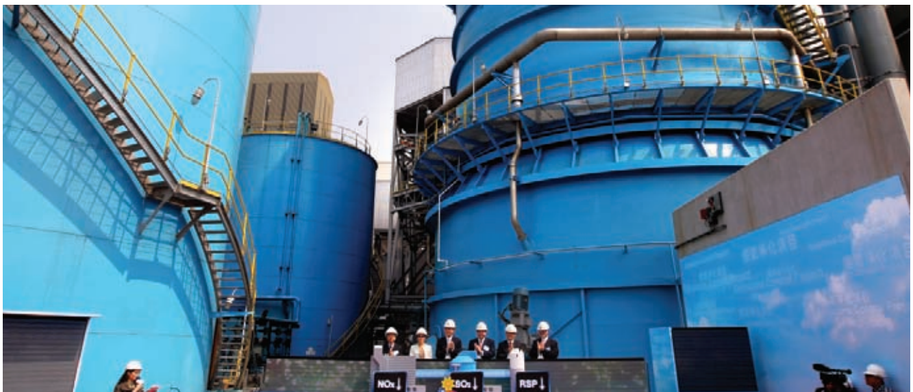
青山發電B廠煙氣淨化項目竣工儀式
