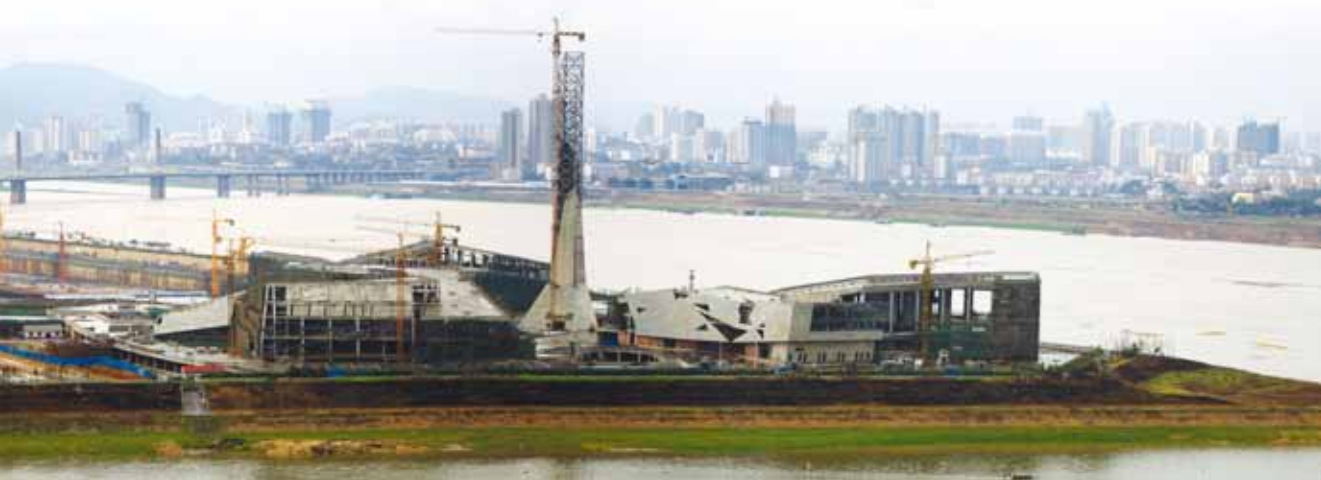
北辰三角洲施工現場鳥瞰實景
