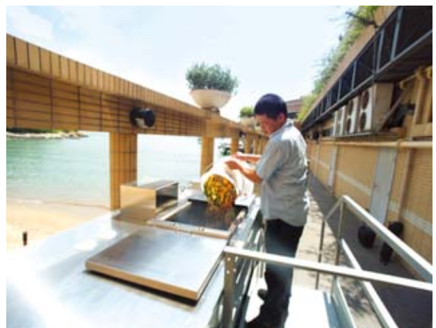
集團部分屋苑設有廚餘處理機，將廚餘分解成為有機肥料
