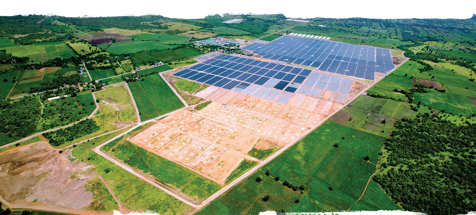
Lopburi 太陽能發電項目
