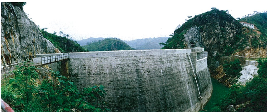
紫金山金铜矿尾矿坝
