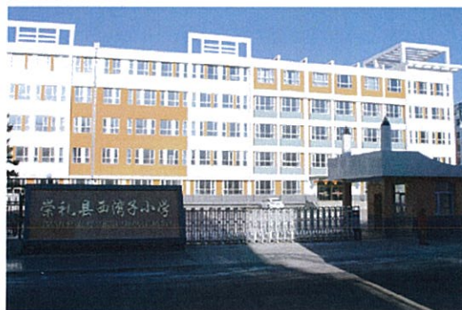
西完小新建教学楼
