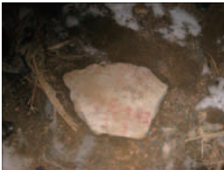
圖7-10：ZK1202地理座標的混凝土柱帽
