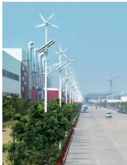
合肥廠區照明燈正利用風能和太陽能提供電力，期望創設更低污染的工作社區
