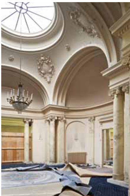
上圖：酒店大樓正進行翻新工程。
