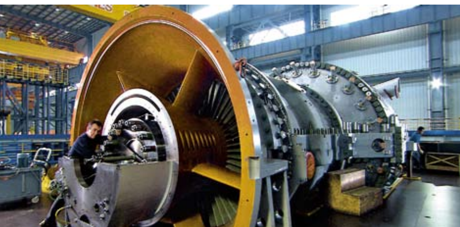
燃氣輪機安裝
