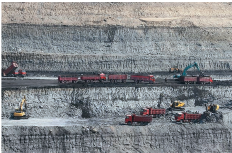
位於內蒙古之新煤礦是集團首個露天煤礦。
