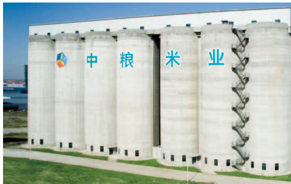
■ 中糧佳悅豆粕倉機械樓
