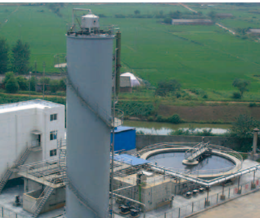
■ 江西米業污水處理站
