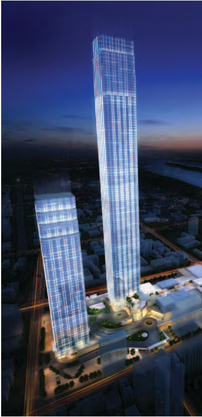
長沙國金中心 (高452米) - 高檔次商場、甲級寫字樓和五星級國際酒店
