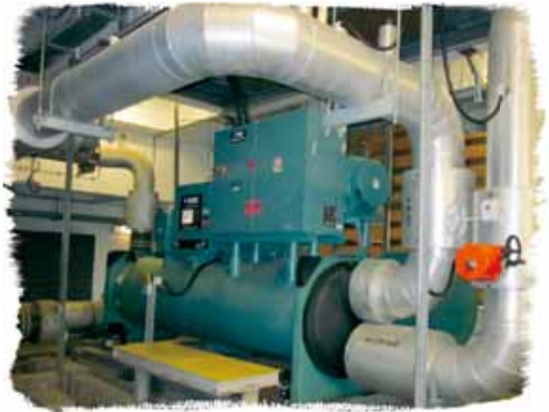
旗下物業組合分階段引入節能效益較高的水冷式冷凍系統
