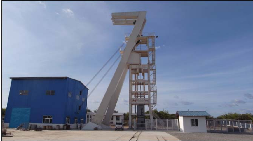
圖7-4：Chambishi 西礦中央副礦井井架
