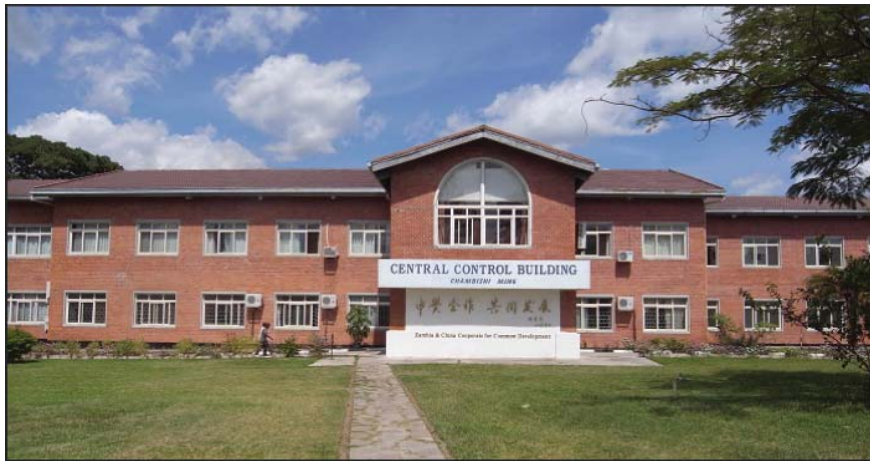
圖12-3：中色非洲礦業辦公樓(「中央控制大樓」)
