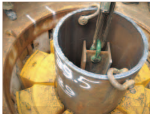
2. Twisting Method - Twist and snap H-pile by rotator 扭動法 - 使用旋轉器扭斷工字樁
