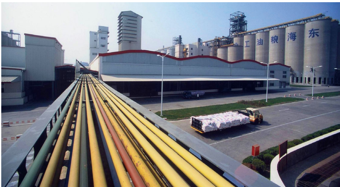
中糧東海糧油輸油管道
