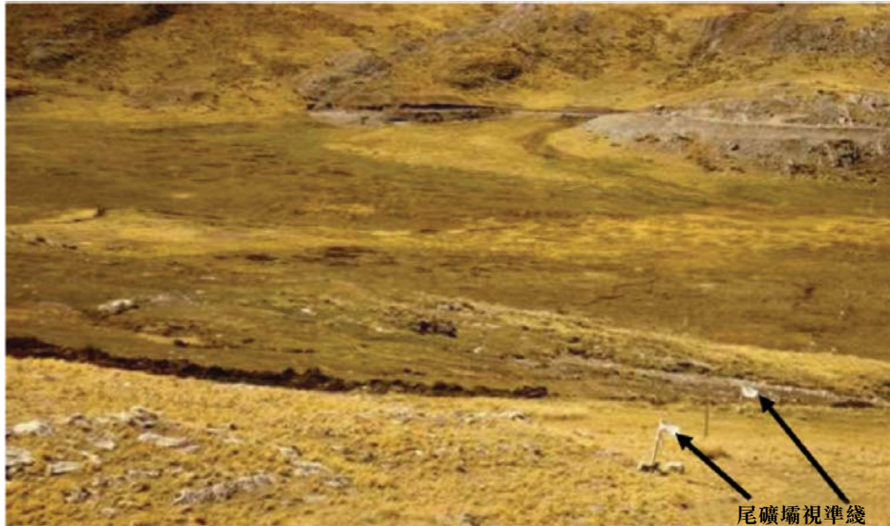
圖13.4. 從 Tunshuruco 山谷的尾礦壩建設區邊緣移走沼澤濕土(「濕地」) (右邊標旗所示為尾礦壩視準綫)
