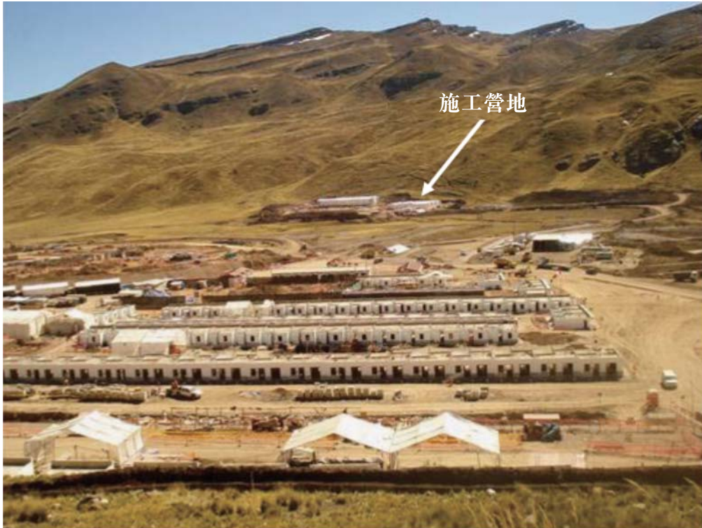
圖13.7. Carhuacoto 新市鎮 (近景顯示新市鎮正在有序建設中，施工營地背靠山脊而建)
