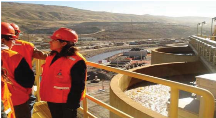
圖13.5. 金斯米爾隧道污水處理廠設施 (建設優良、運行良好，可處理 Toromocho 山頂地區以往的礦山排水，為新採礦項目提供加工用水)
