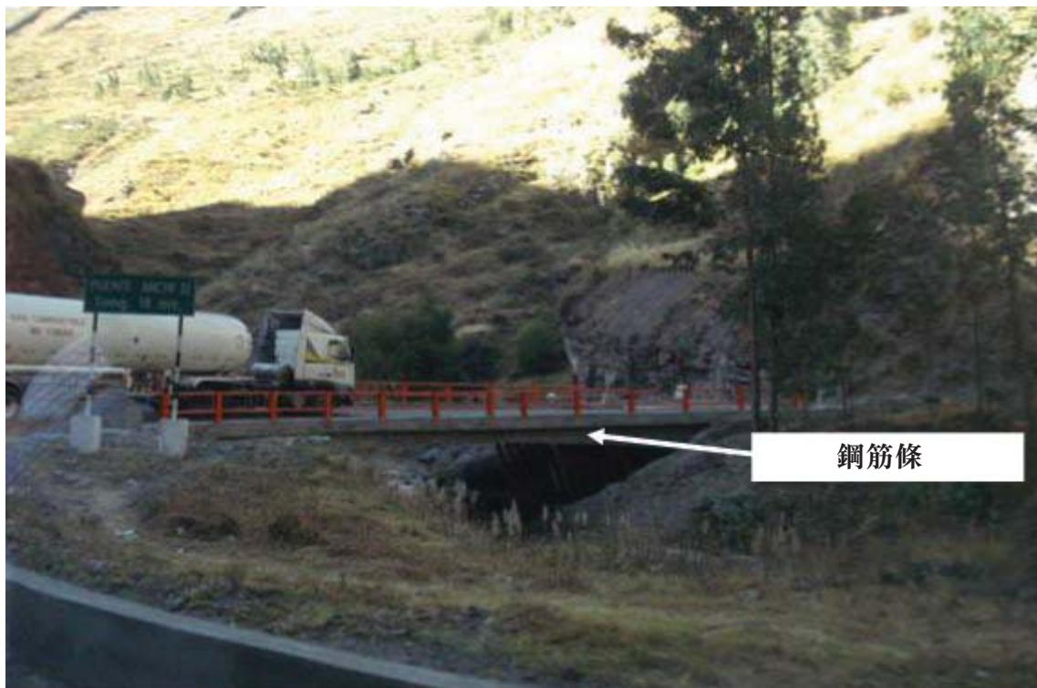
圖13.8. 利馬中央公路路況 (包括新的橋樑改良工程，以及中鋁秘魯在橋面底板處安裝紅色鋼筋條(在右側橋面底板處隱約可見)，以應付主要的設備與物資運輸)
