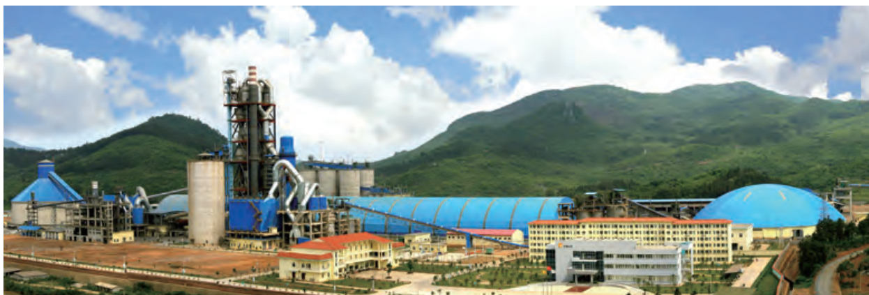
我們位於廣西華潤賀州循環經濟園的水泥生產基地
