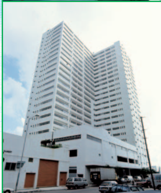
香港鴨脷洲 海灣工貿中心
