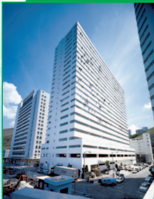
香港鴨脷洲 港灣工貿中心
