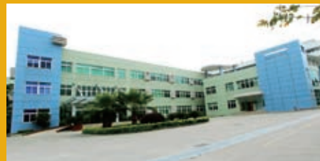
位於廣東中山的油墨廠房 The inks plant in Zhongshan, Guangdong
