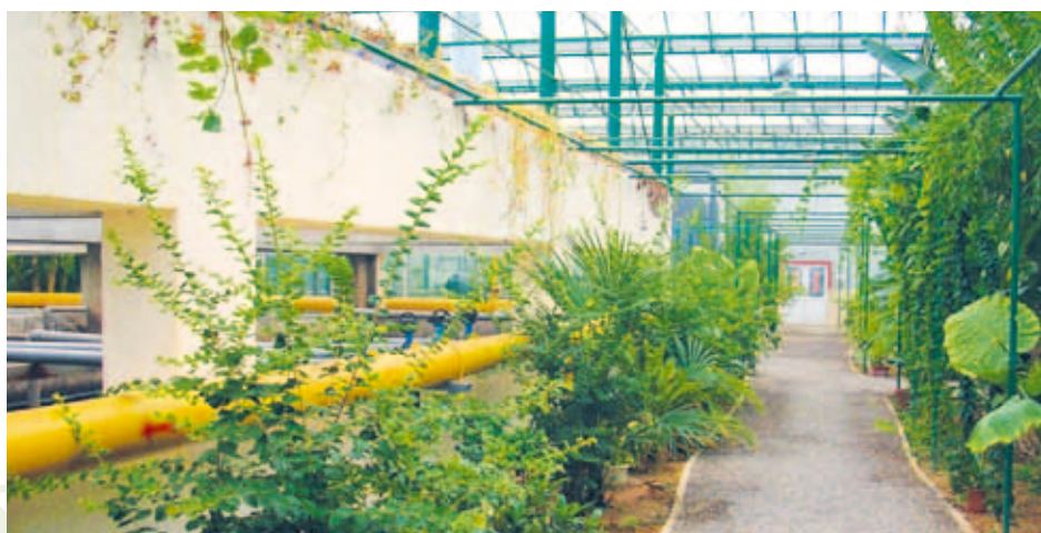
Huaxia Sewage Treatment Station 華夏污水處理站
