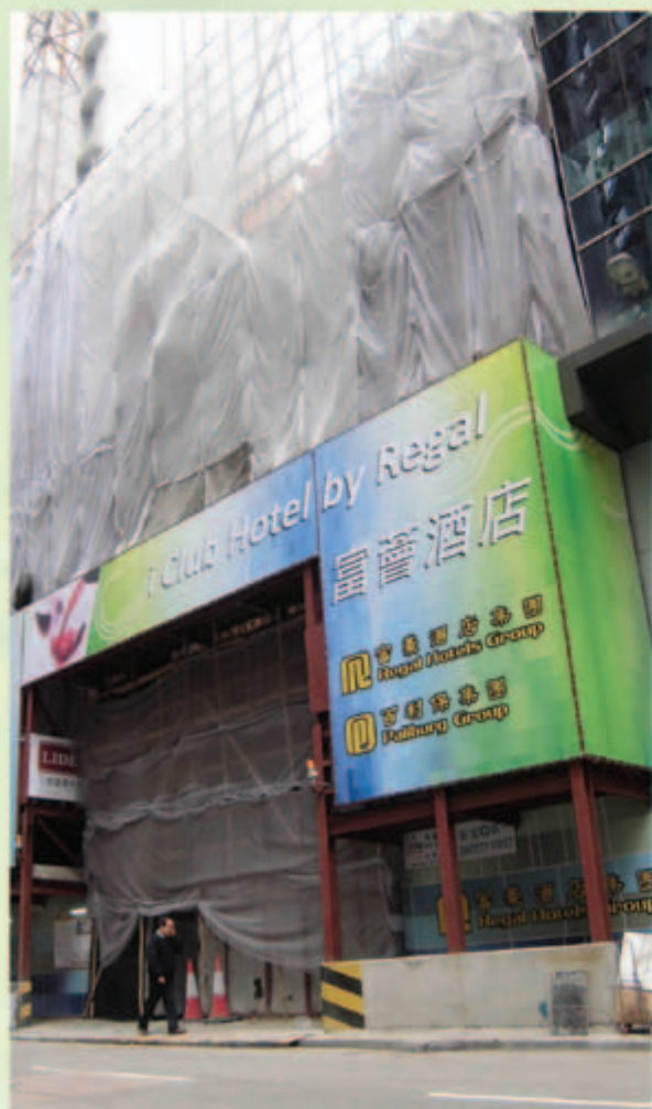
■ 位於香港北角麥連街 14 至 20 號之酒店發展項目之上蓋建築工程現正在進行
