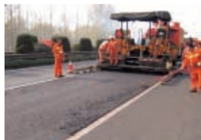
鋪設充分攪拌的回收混合料
