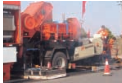
充分攪拌回收的混合料並採用熱粘結技術再加熱路面
