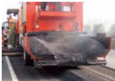
在原有瀝青混合料上添加新的瀝青混合料，製成回收的混合料
