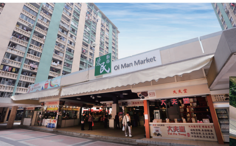
愛民街市—領匯旗下第二個完成資產提升的街市
