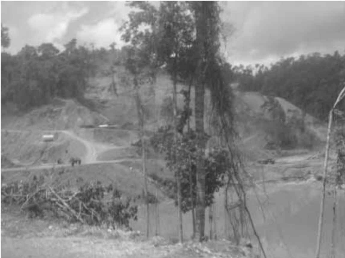
照片5：儲存徑流及排水的蓄水池
