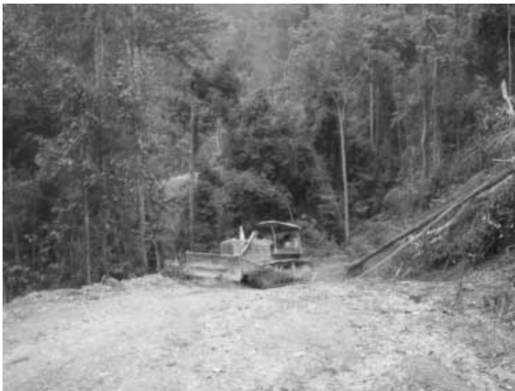
照片2：尚未完成的鑽探交通路線
