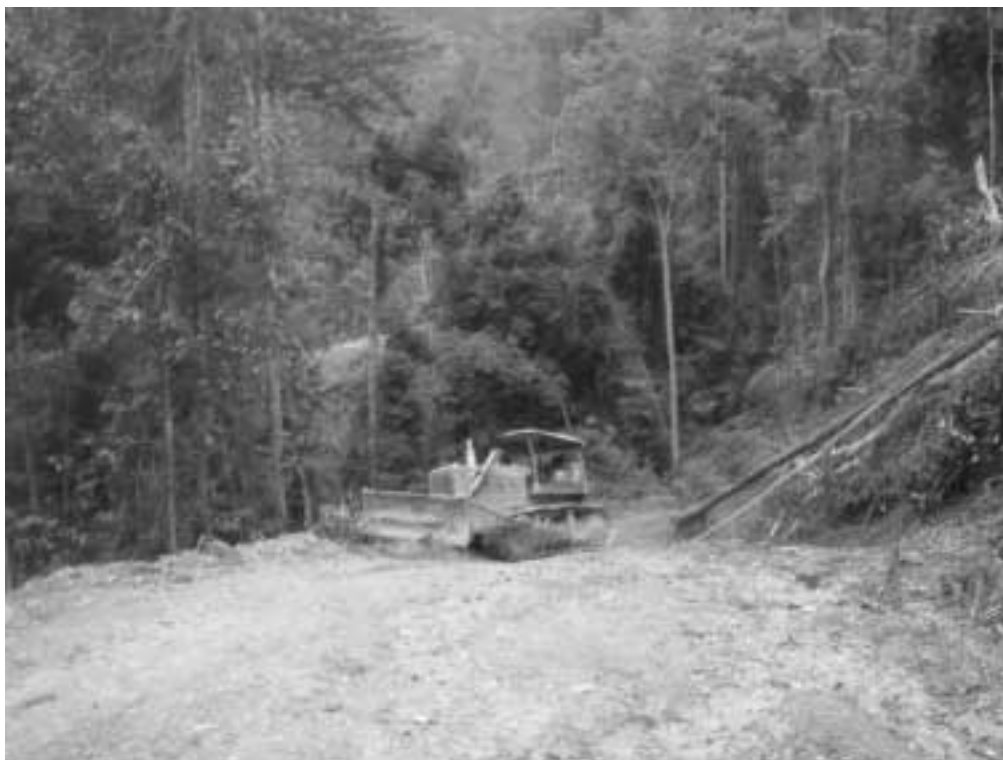
照片2：尚未完成的鑽探交通路線
