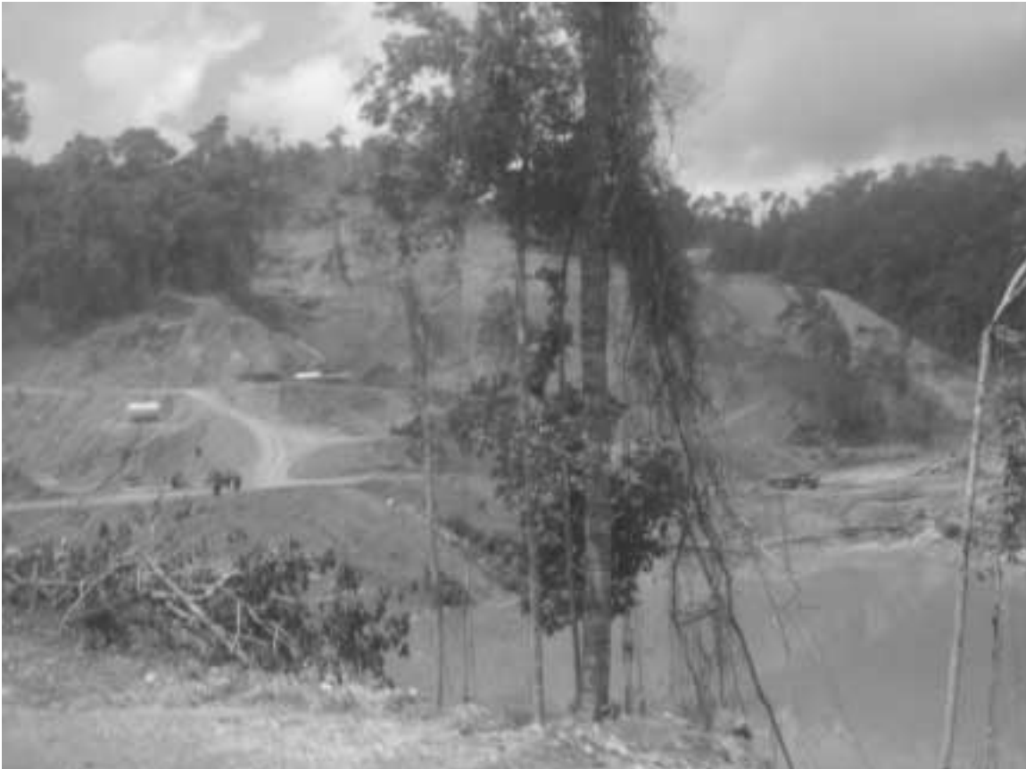
照片5：儲存徑流及排水的蓄水池
