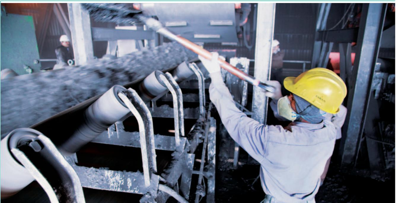
技工正在維修哈格爾電廠的燃煤輸送系統
