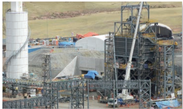
頑石破碎及給料隧道
