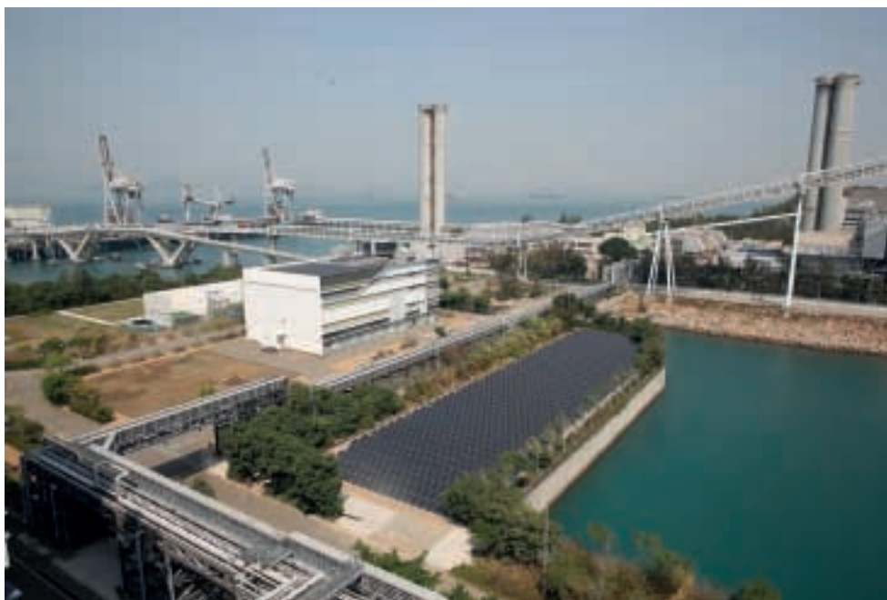
南丫擴建的薄膜光伏組件
