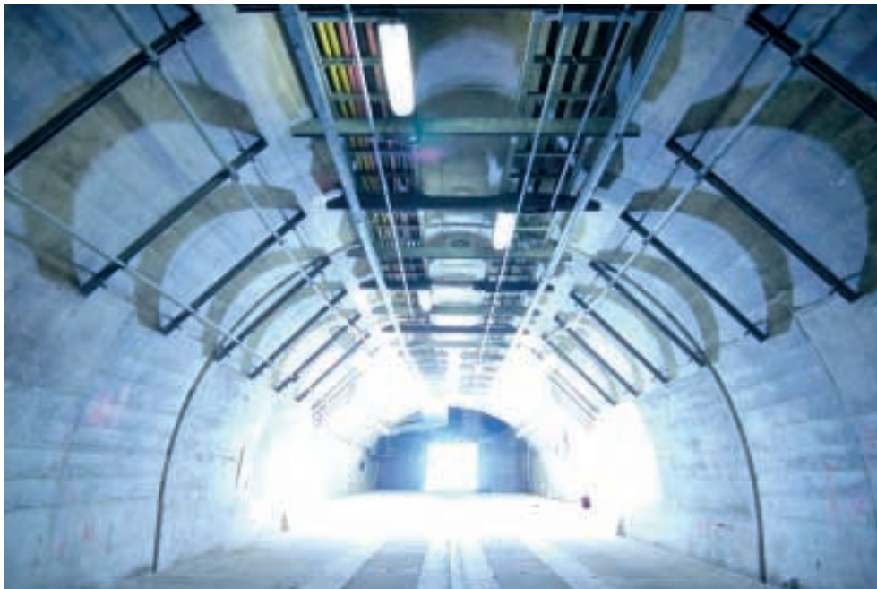
香港首條電纜隧道，華富至寶雲電纜隧道
