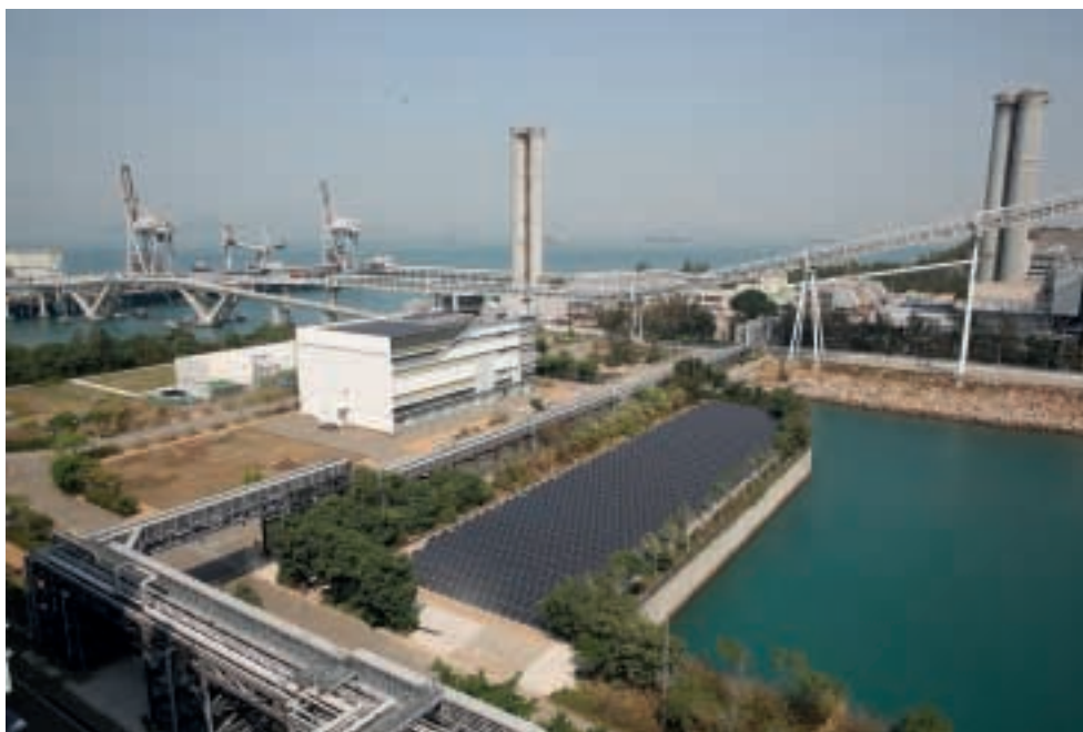
南丫擴建的薄膜光伏組件
