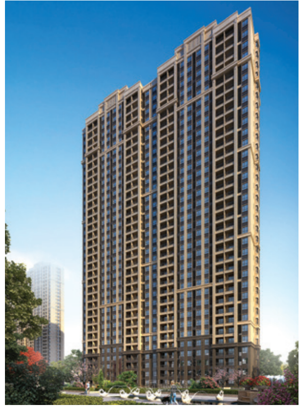
鹽城 — 中海世紀公館
