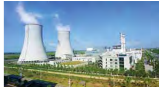
浙江绍兴燃机、江山燃机项目投产。绍兴两台 45.2 万千瓦机组为国内建成投产的单机容量最大燃气机组
