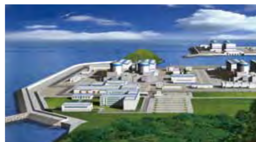
2013 年 4 月 15 日，宁德核电站一期 1 号机组完成试运，正式投入商业运行，标志着大唐国际核电实现了“零”的突破
