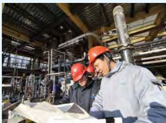
二氧化碳捕集量为 5 吨 / 天的示范装置
